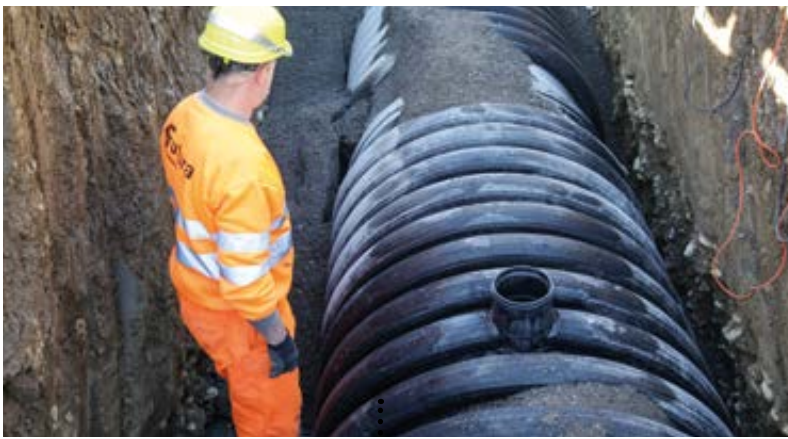
Intervento di saldatura 1200 - Belforte all'Isauro (PU)
