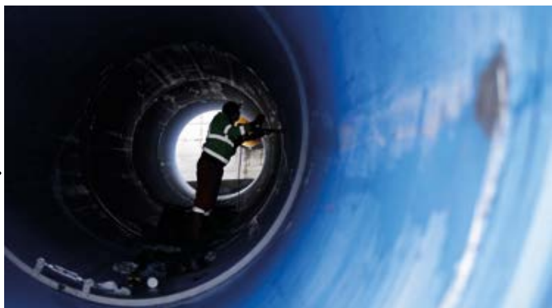
Intervento saldatura 2000 - Genova (GE)
