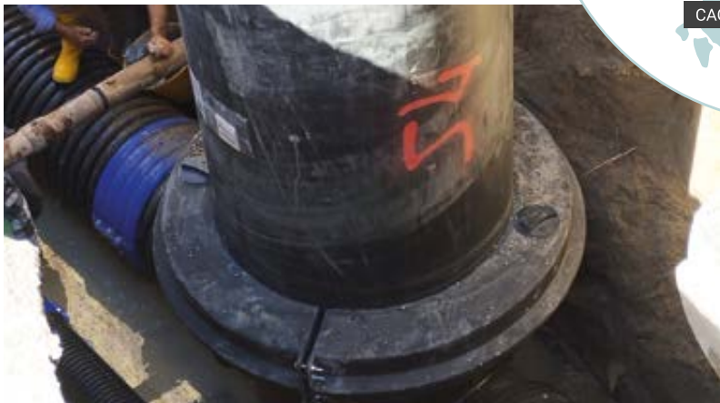
Pozzetti formati antifalda Ø1000 - Cagliari (CA)
