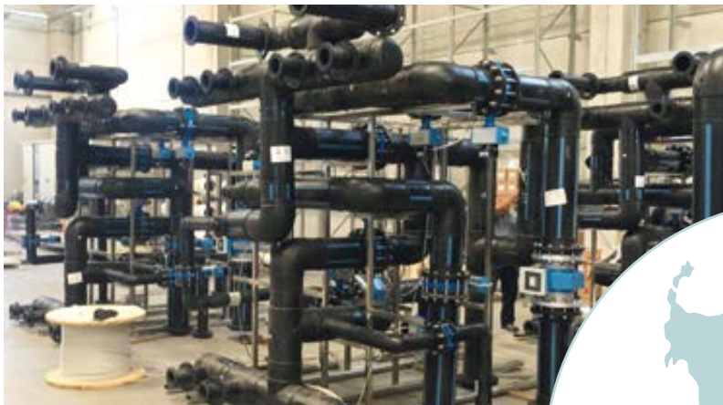
Collettore Ø125 PN16 SDR11 PE100 - Macchiareddu (CA)
