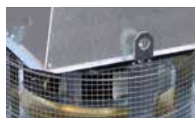
Montaggio facile Golfari per un sicuro e facile montaggio a tetto.
