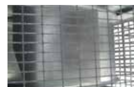
Griglia di protezione anti volatile in acciaio zincato.
