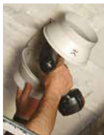
Fissaggio del supporto.
