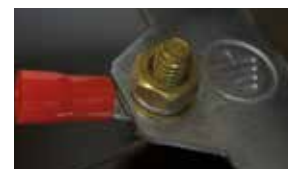
Messa a terra
