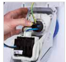
Connessione del conduttore di terra senza viti, max Ø 4mm; Ø 10mm su 32A.
