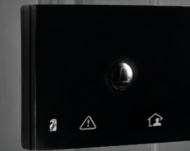
Segnalazioni DND MUR, Campanello
