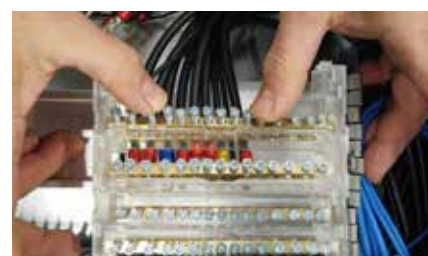
Cablaggio per singola barretta Wiring per each bar
